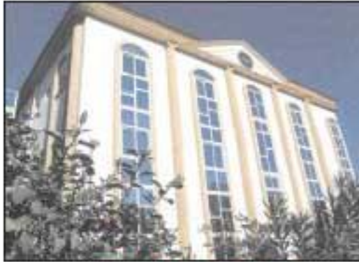
مبنى سوهاج على الطراز الروماني لتناسب عراقة وأصالة مصر للبترول
